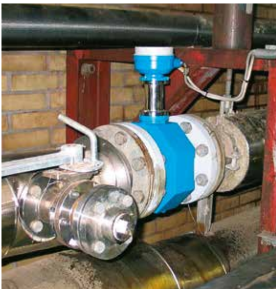
Magneettinen virtausmittaus sellutehtaan mustalipeälinjassa.
