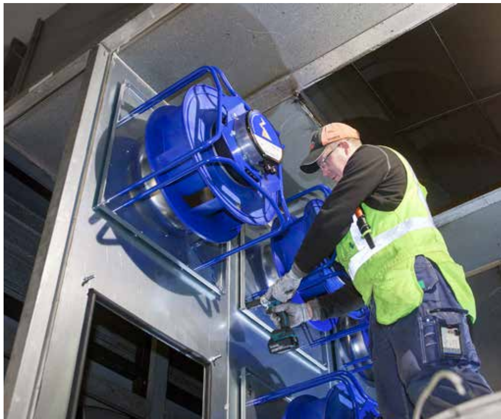
Modernit ja hiljaiset ilmastointilaitteet korvaavat vanhat ja tehottomat koneet. Asennustöissä Lasse Rämä.
